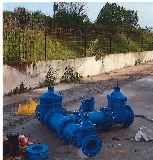
Canalisation: au pied du talus SNCF, assemblage d'un té de dérivation pour le raccordement sur le réseau existant.
